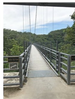
舌震の“恋”吊橋。
